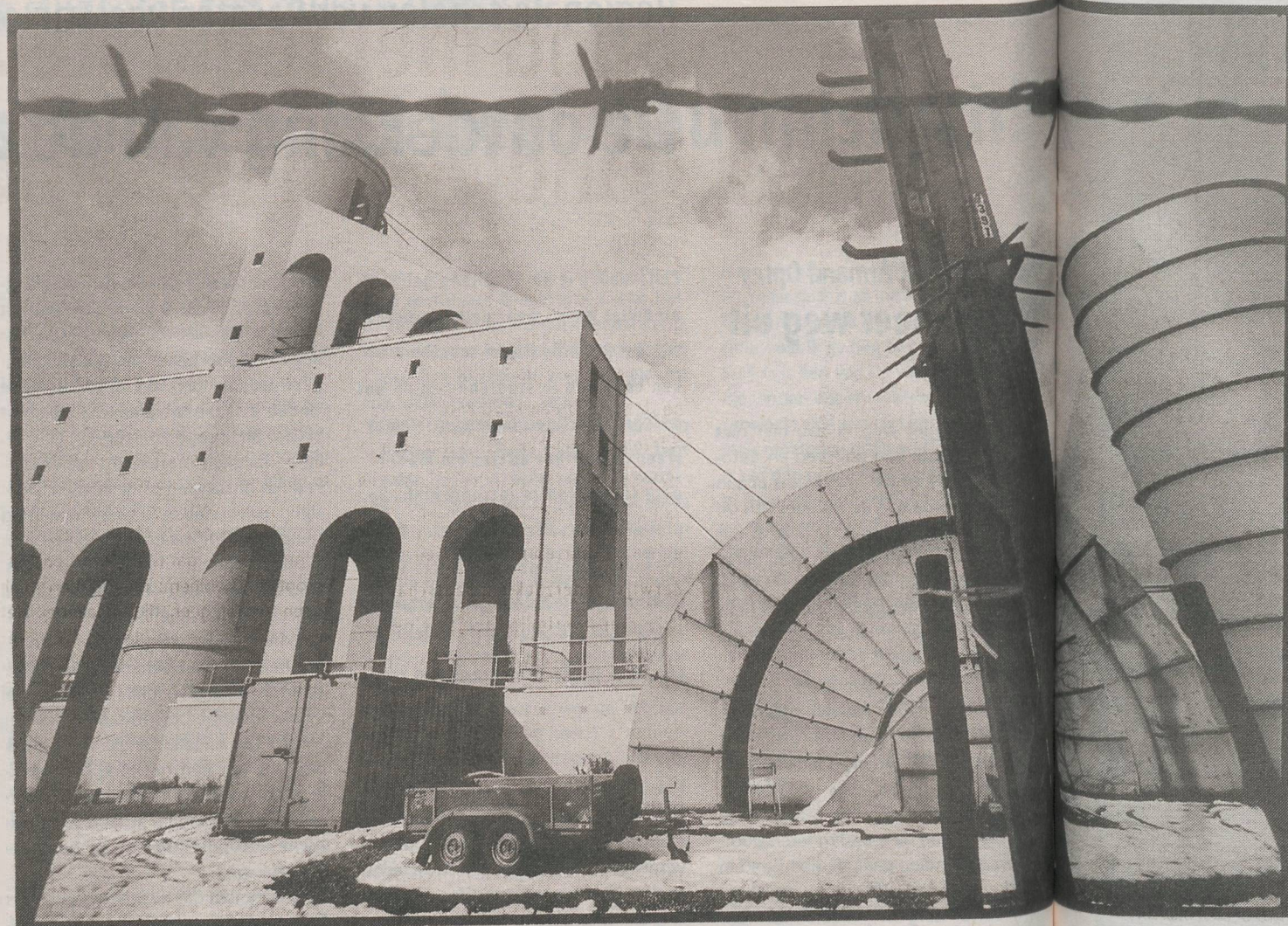
Nulland schacht in Kerkrade
