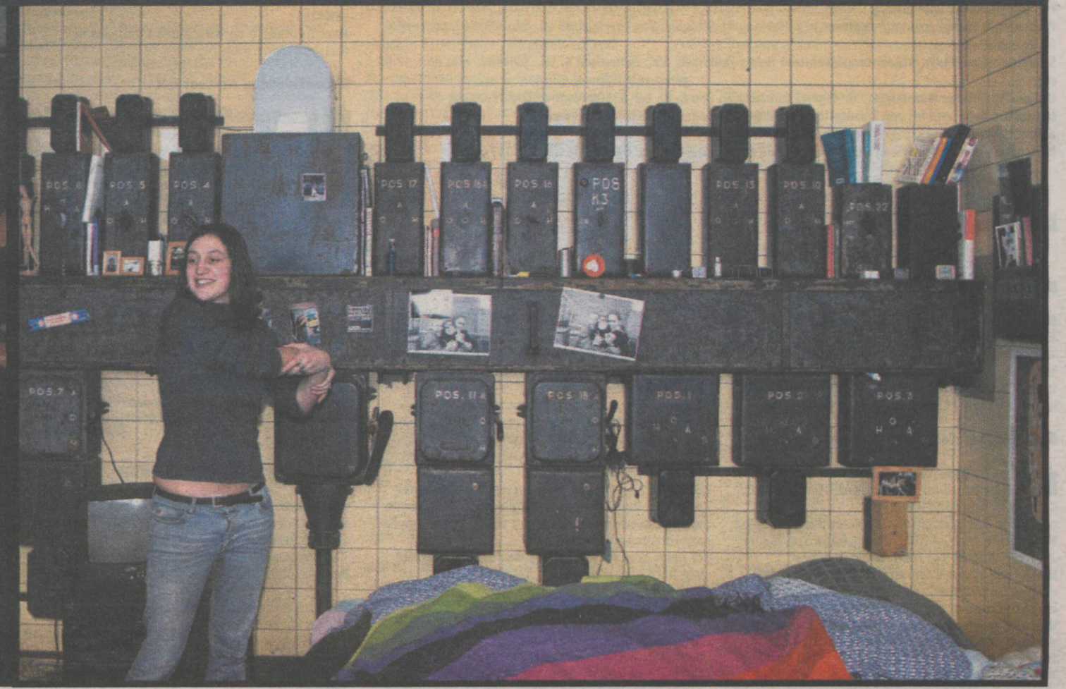
Laura slaapt in de oude machinecontrolekamer
