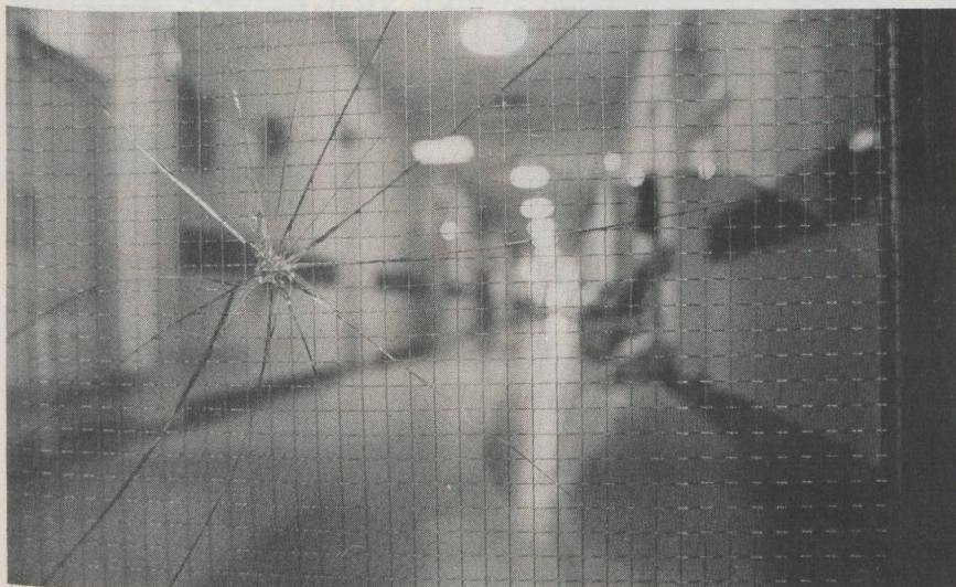
Het ziekenhuis Sint Annadal is gebouwd volgens een verouderd concept uit de jaren dertig en verkeert in slechte staat van onderhoud. Volgens Verheij is verbouwing tot Akademisch Ziekenhuis daarom duurder dan nieuwbouw.
