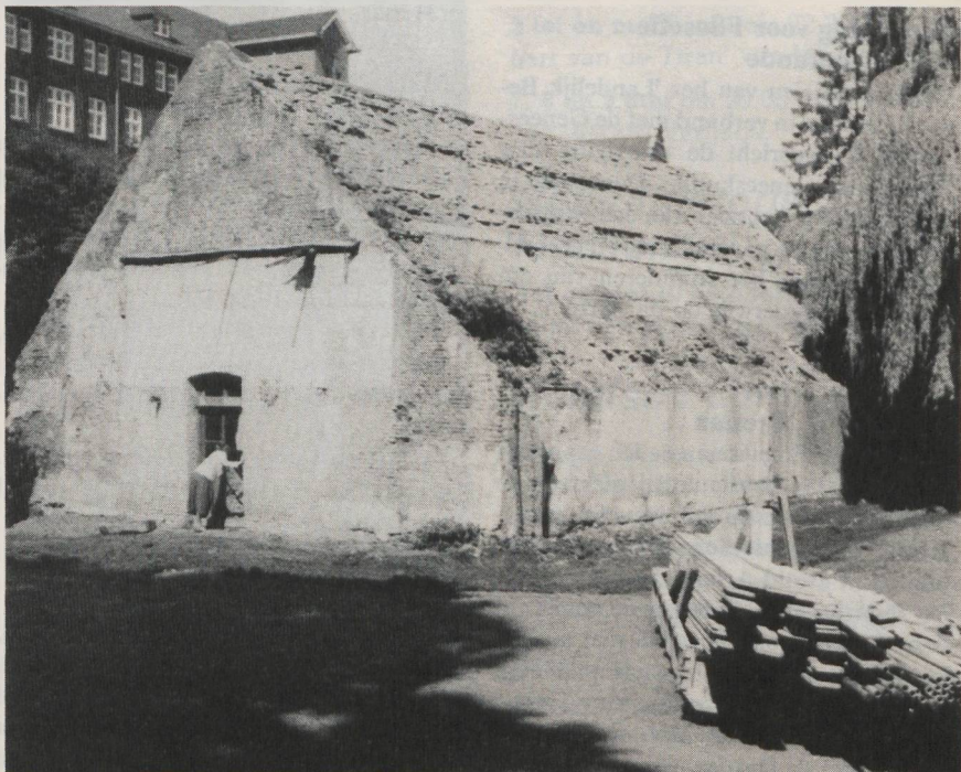
Het Kruithuis tijdens de restauratie
