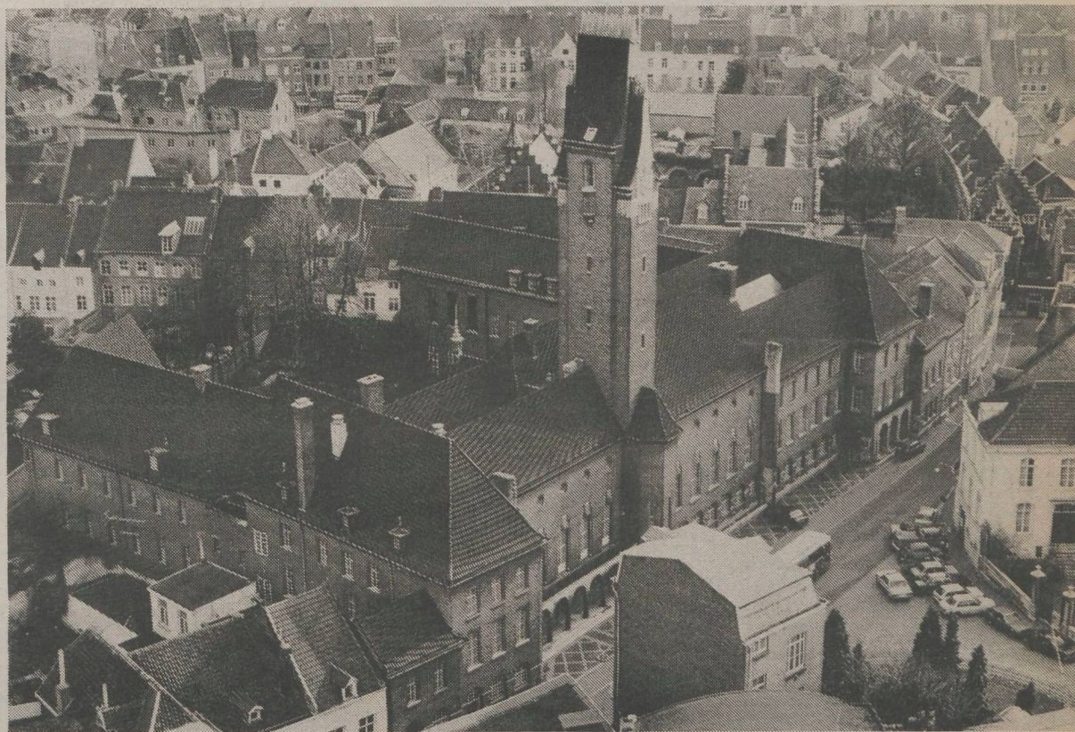
Bouillonstraat 3, het belangrijkste van de provinciegebouwen. De vergaderzaal van Provinciale Staten zal verbouwd worden tot collegezaal met vier- à vijfhonderd plaatsen.
