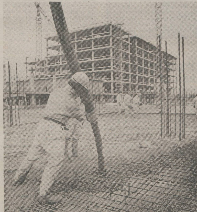
De ene overgang is nog niet voltooid, of de andere wordt al voorbereid. Over vijf jaar verlaat Ziekenhuis Maastricht het Annadalgebouw om zich in de nieuwbouw op Randwyck te vestigen. Tegen die tijd is het beton zeker hard.
