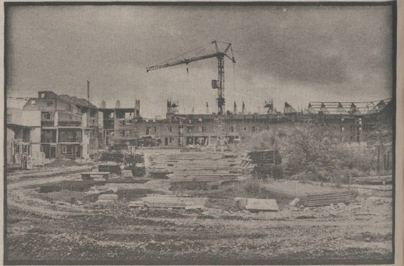
Werkzaamheden op het bouwcomplex waar men mensvriendelijk wil gaan wonen (foto Franco Gori)
