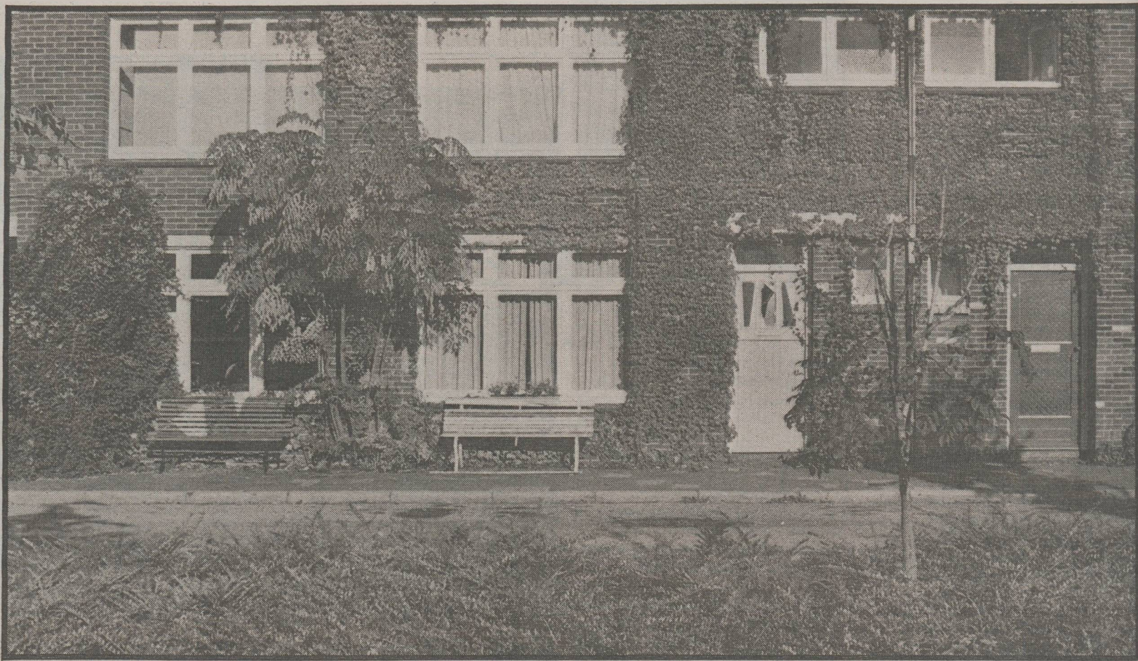
De Ravelijn-buurt: lekkende WC-potten voor woningverbetering (foto Franco Gori)
