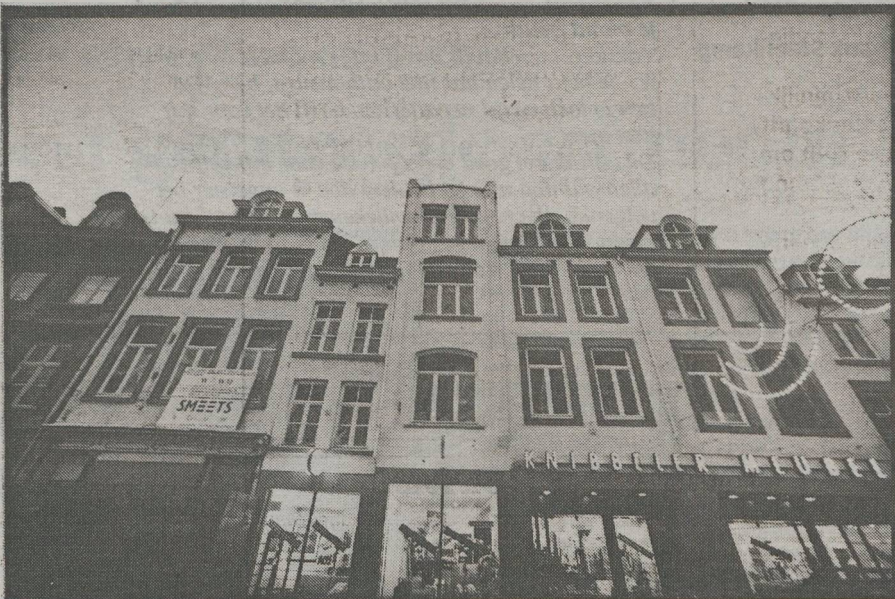
Het grootste project van WbWM tot nu toe: de verbouwing van de bovenverdiepingen van een meubelzaak aan de Grote Gracht, waar dertig studentenkamers moeten komen. (foto Nelis Tutkey)
